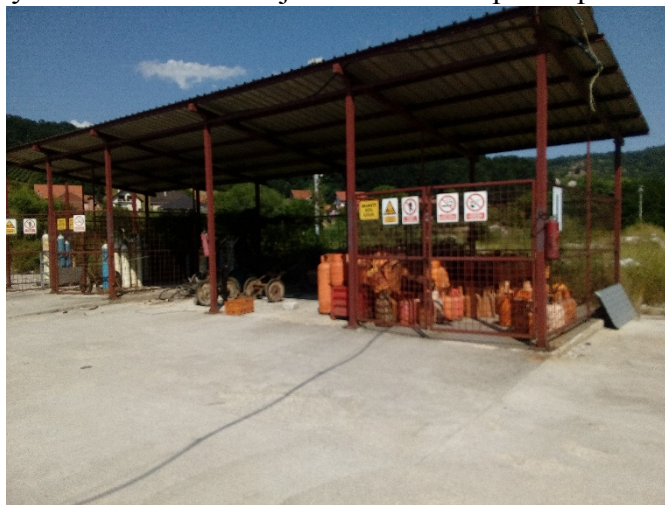
Слика 11. Складиште техничких гасова на локацији оператера
