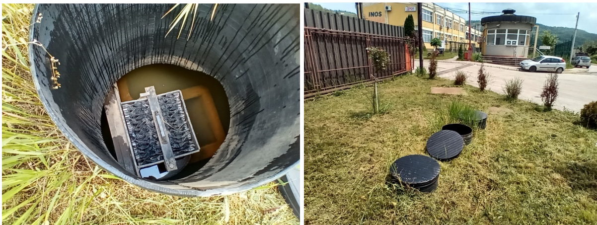
Слика 12. Уграђен сепаратор уља са коалесцентним филтером
